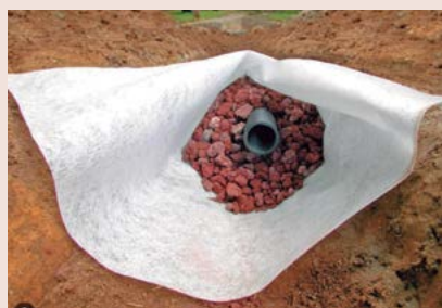
Creación de un sistema de drenaje con la excavación de un canal, relleno de rocas y recubierto de una tela de geotextil.
